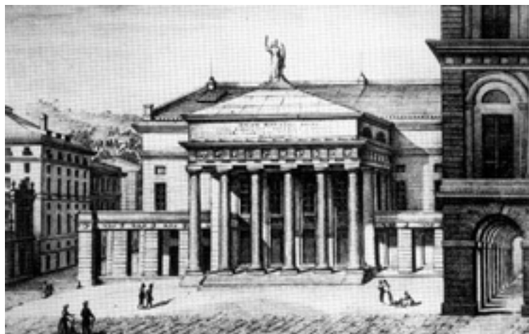
Vista del Teatro Carlo Felice de Génova.
