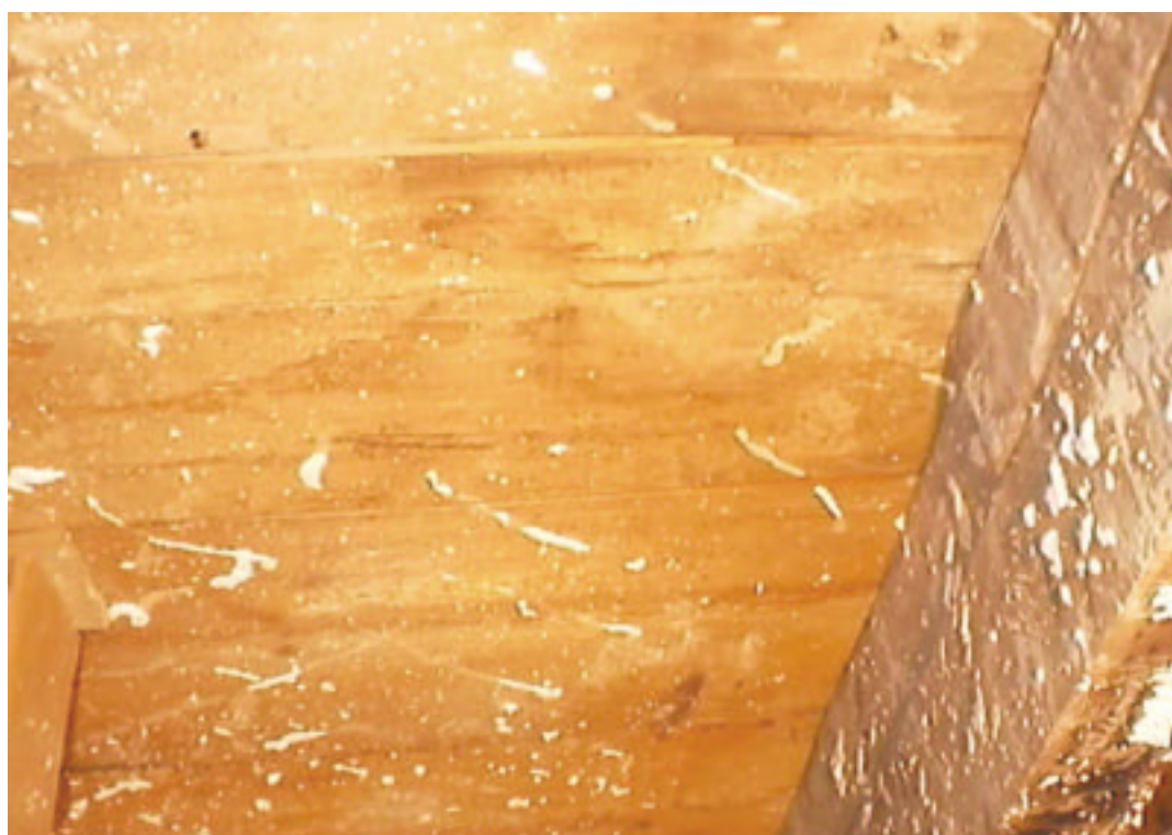
Fotografía 21. Se aprecia en el sector A el entablonado machihembrado de pino blanco de 1 1/2" x 12" sobre tirantes y regresos de madera dura.
