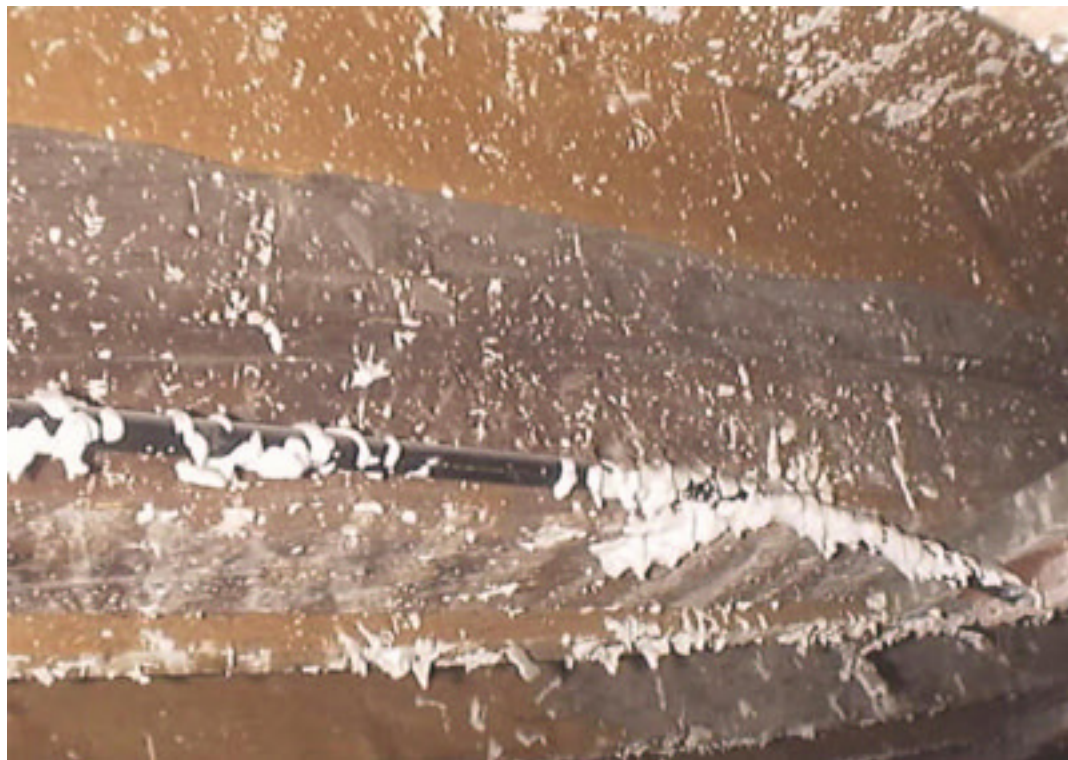
Fotografía 29. Detalle de tirante de madera dura hachuelado. Se observa la madera desgarrada, hecho debido a los cortes con la hachuela, que no representa ningún efecto para su estado de conservación.
