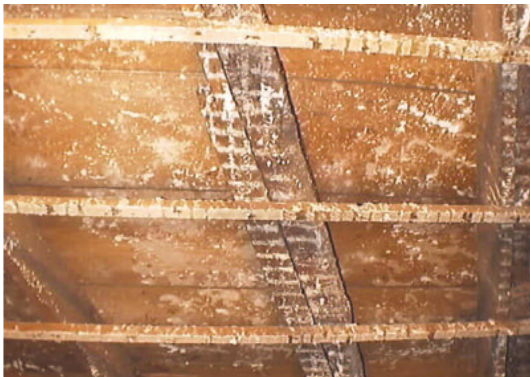
Fotografía 34. Sector B. No hay regresos sobre la tirantería de madera dura. El entablado es de pino blanco machihembrado de medidas sumamente regulares (1 1/2" x 12").
