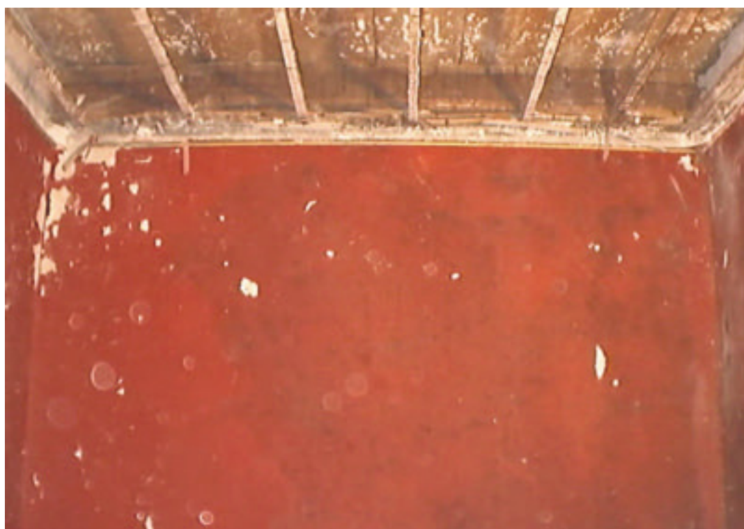
Fotografía 32. Vista general del muro y el tirante de la situación planteada anteriormente.
