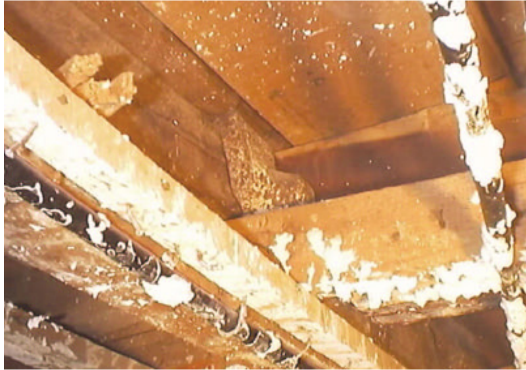
Fotografía 35. Sector C. Se aprecia el detalle de los caballetes metálicos que realizan el vínculo de apoyo entre un tirante y otro. Se registran la cantidad y sus posiciones en los gráficos que se adjuntan.
