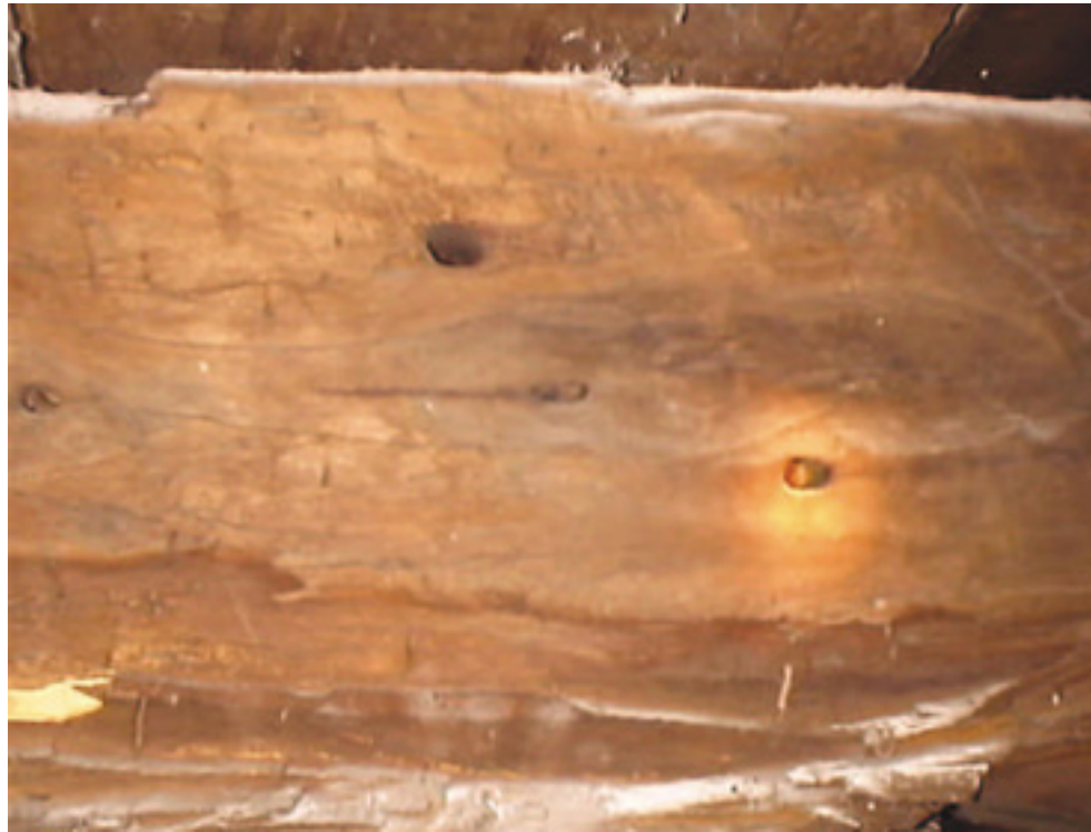
Fotografía 5. Se aprecia claramente el tamaño y las características de los agujeros realizados por el taladro.
