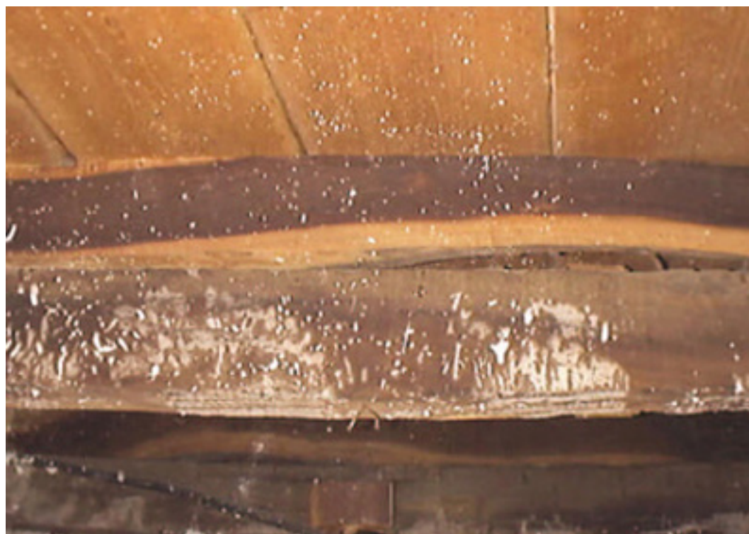
Fotografía 9. Se observa la conformación de tirantes y entablado correspondientes al sector de palcos secretos: tirante de madera dura con regreso superior también en madera dura; entablado de pino blanco machihembrado de 1 1/2" de espesor por 12" de ancho.
