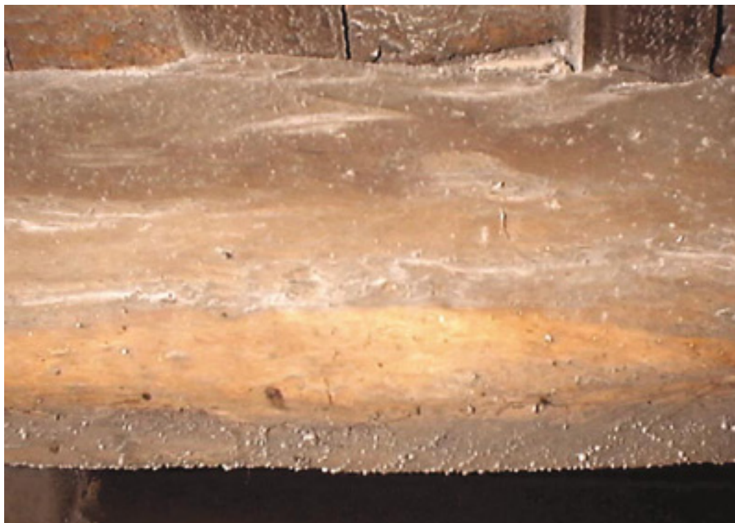
Fotografía 2. Vista de otro tirante de madera dura. Se observan rastros de agujeros de polillas en idéntica situación que la registrada en la imagen anterior. Se identifica claramente la presencia de sámago en el tirante. Vale el mismo diagnóstico que para viga de la fotografía 1.
