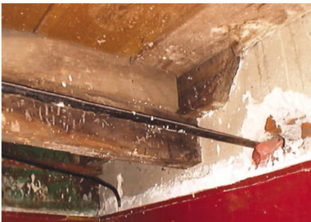
Fotografía 10. Muestra el apoyo entre tirantes y el suplemento del regreso en el cual apoya el entablado antes mencionado.
