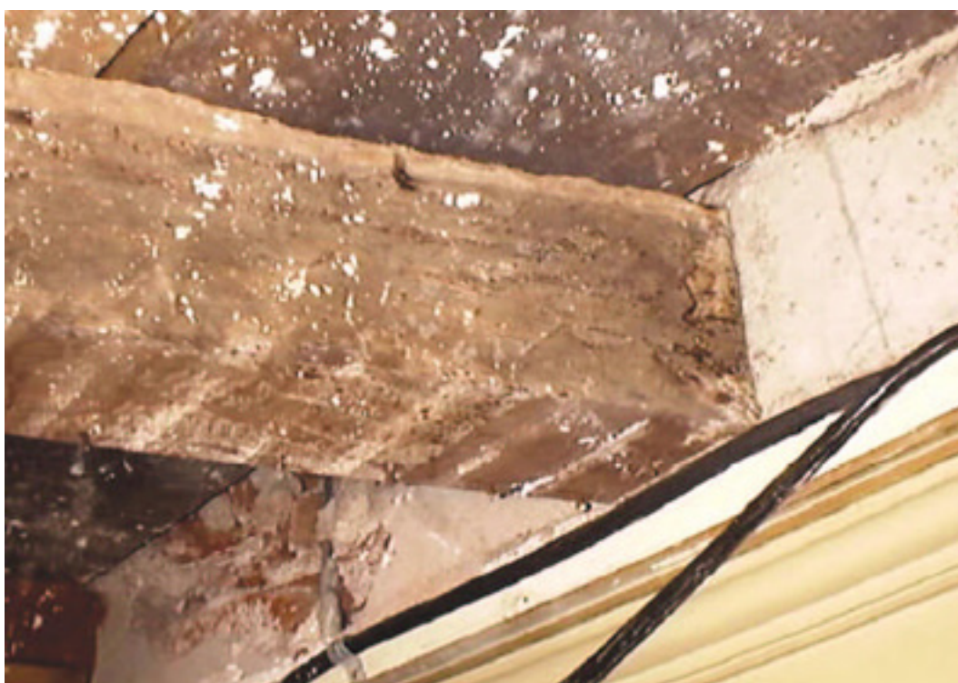
Fotografía 14. Detalle exterior del anclaje del tirante de madera dura sobre uno de los muros maestros. El estado de conservación es excelente. Esta situación se generaliza para todos los niveles. Más adelante se observará el estado de conservación del sector mismo del tirante sobre el muro, a través de los cateos realizados in situ .
