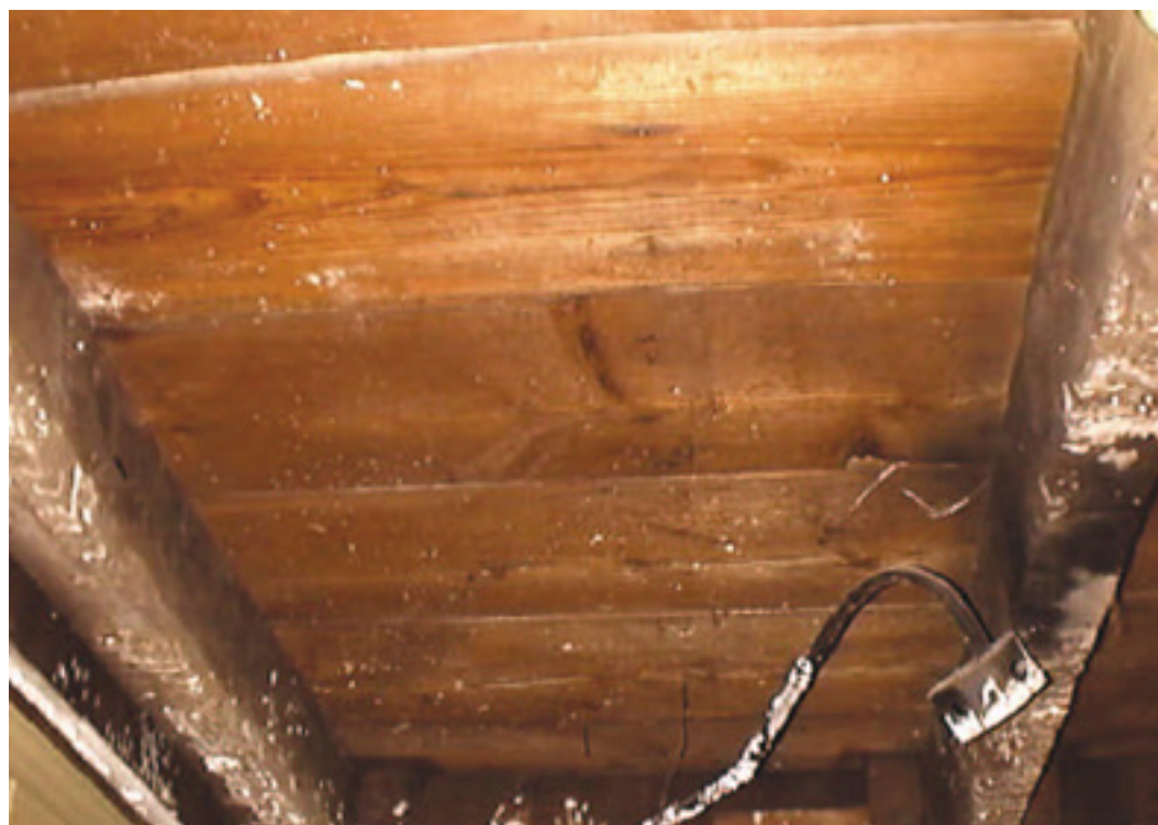
Fotografía 13. Se aprecia claramente el entablonado de pino blanco machihembrado de 1 1/2" x 12", que recibe el pavimento de madera del nivel superior.
