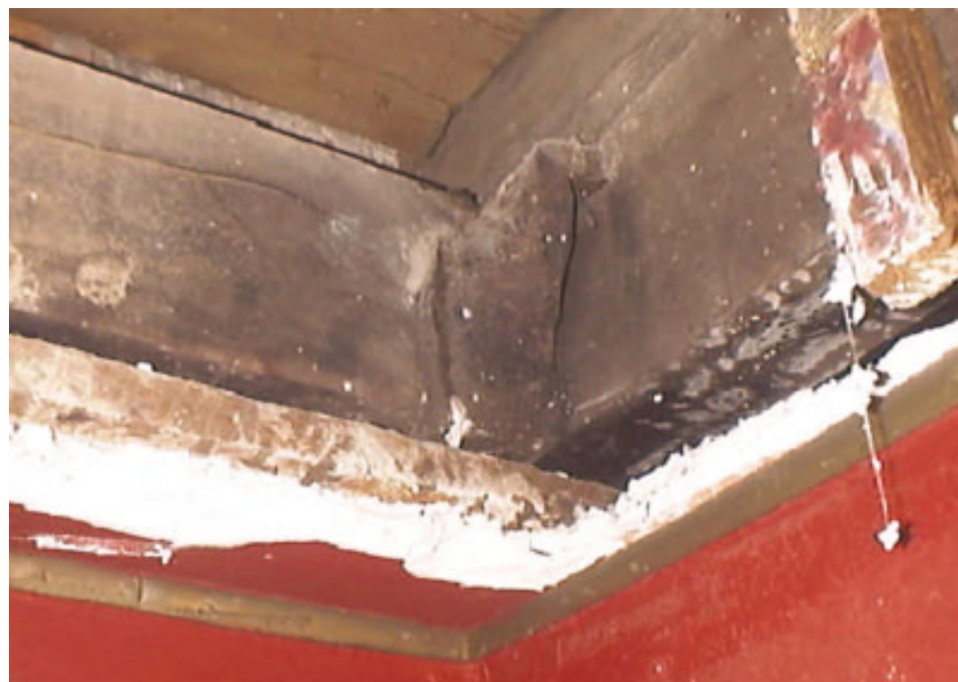
Fotografía 20. Otro detalle de sujeción entre tirantes de madera dura a través de estribos metálicos, similar al visualizado en la fotografía 3.
