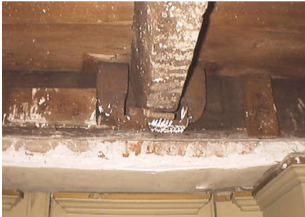
Fotografía 12. Se observa la presencia de estribos metálicos que offician de vínculo-sostén entre los tirantes de madera dura.
