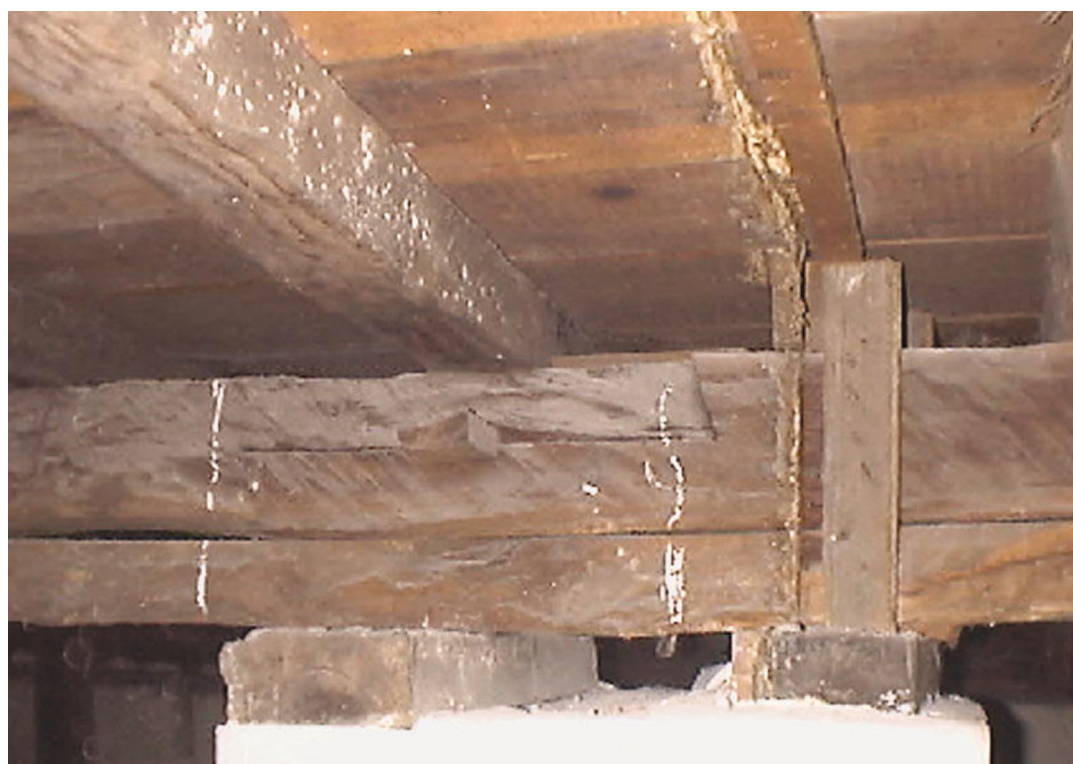
Fotografía 1. Se observan los distintos elementos constructivos de la estructura. Se aprecia el asentamiento de las vigas principales sobre las bases de mampostería a través de los suplementos de madera; las ensambladuras a rayo de Júpiter con llave de las vigas principales; los tirantillos de madera dura y el entablado inferior de pino blanco de 1 1/2".
