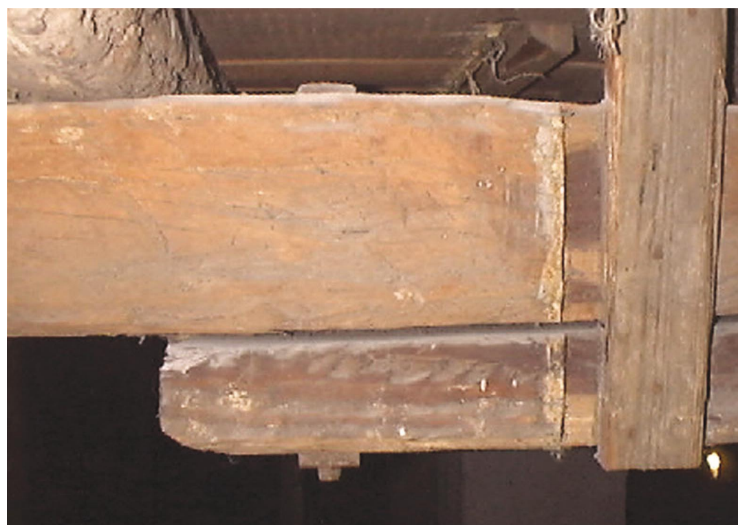
Fotografía 2. Detalle de la sujeción a través de bulones pasantes con tuerca y empalmes de madera de la viga principal a los suplementos de madera posicionados sobre las bases de mampostería. Es de resaltar que dicha situación se presenta en las uniones de vigas cuya base de mampostería no son las centrales.
