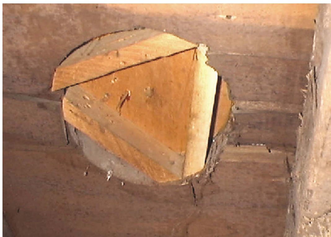
Fotografía 3. Detalle del entablado inferior de pino blanco de 1 1/2». Se observa a través de los orificios la sucesión de los distintos componentes del entablado y terminación.
