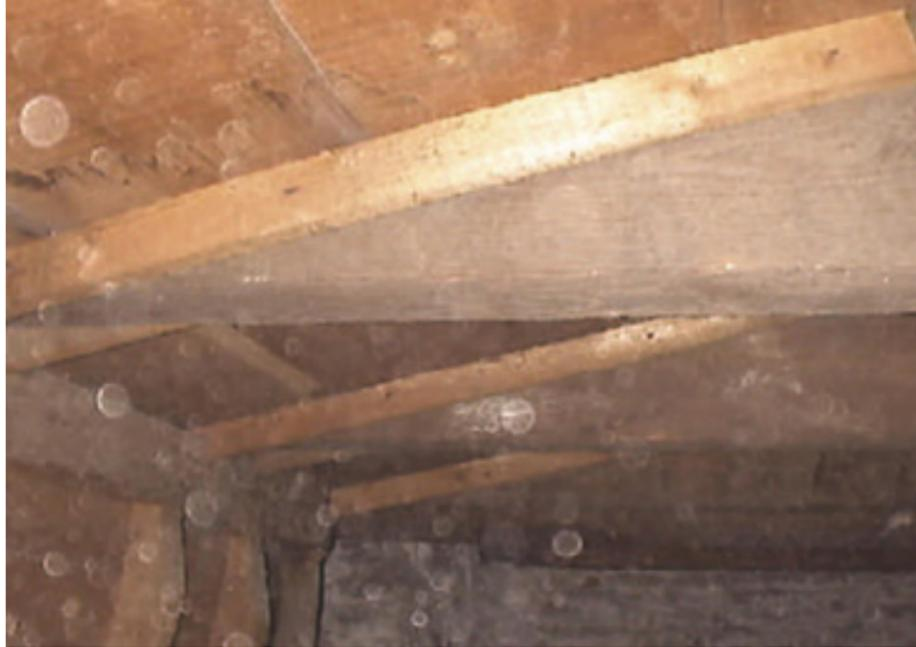
Fotografía 8. Detalle en el que se aprecian las vigas principales (5" x 9") de las cuales cuelga la estructura de la caja propiamente, el forro lateral conformado por tablas machihembradas de 3/5" x 30 cm y los listones de soporte (2" x 1").
