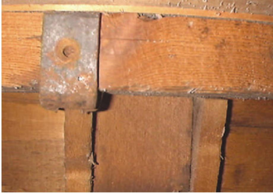
Fotografía 11. Detalle inferior de grampa metálica de sujeción.
