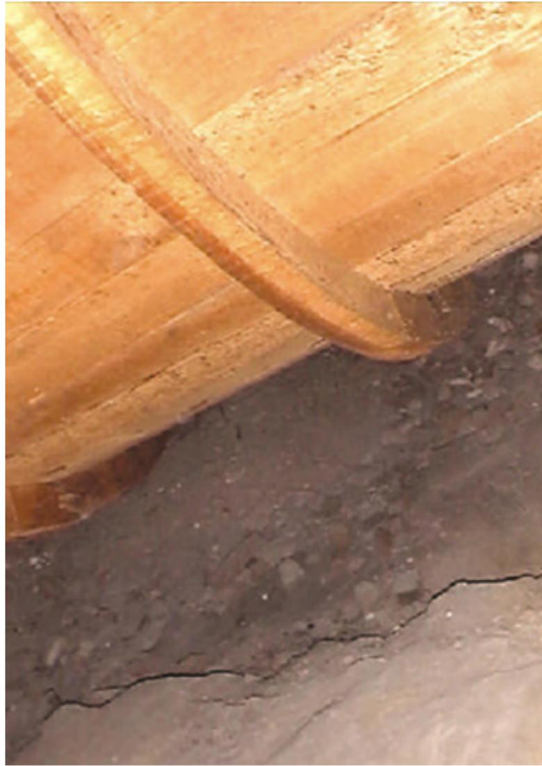
Fotografía 4. Se observa el entablonado machihembrado de pino blanco de 3/5" (forro "de barca") y sus costillas transversales.
