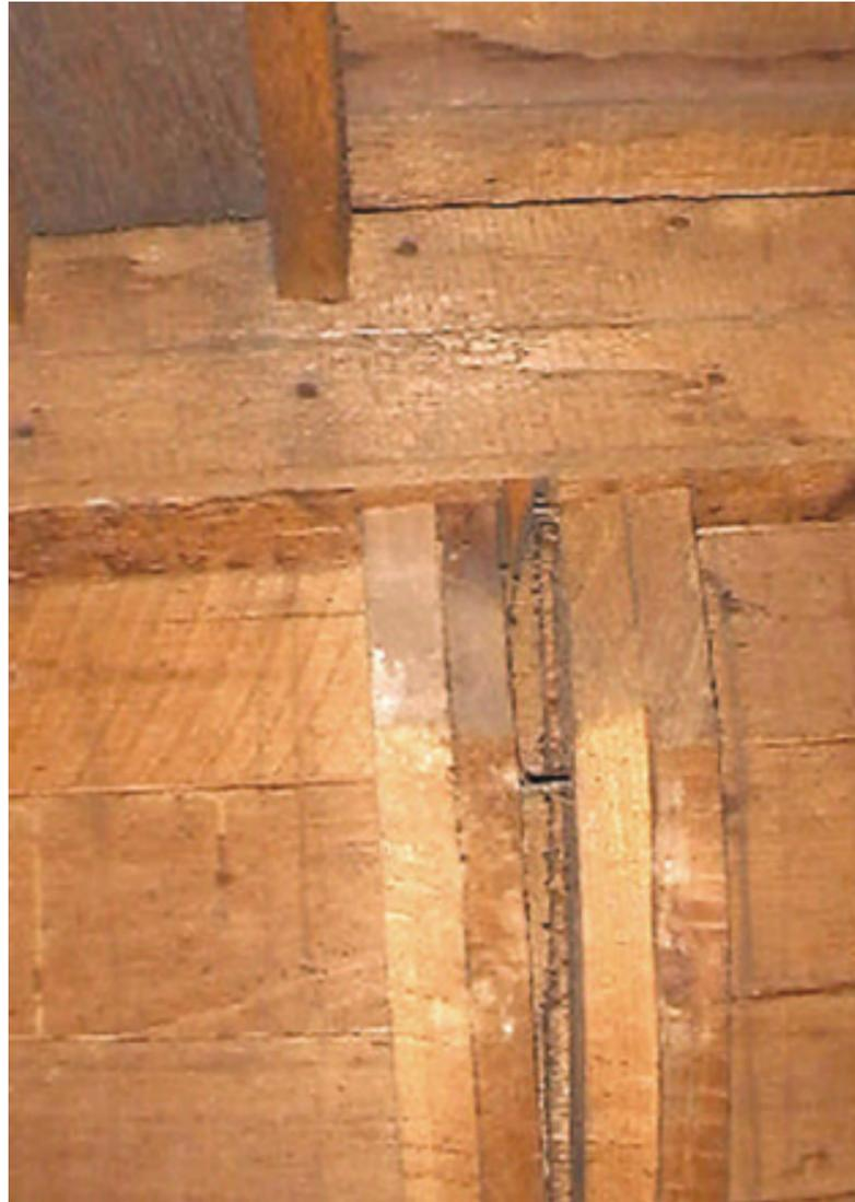
Fotografía 6. Detalle de la unión de los dos tramos en que está construida la estructura. Se visualiza claramente por la aparición de una doble costilla transversal, cada una con la conformación antes descrita.
