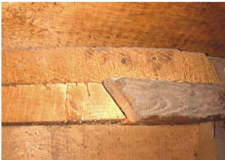
Fotografía 5. Sector correspondiente a la costilla perimetral del borde superior. Se observa el ensamble entre las secciones de madera.
