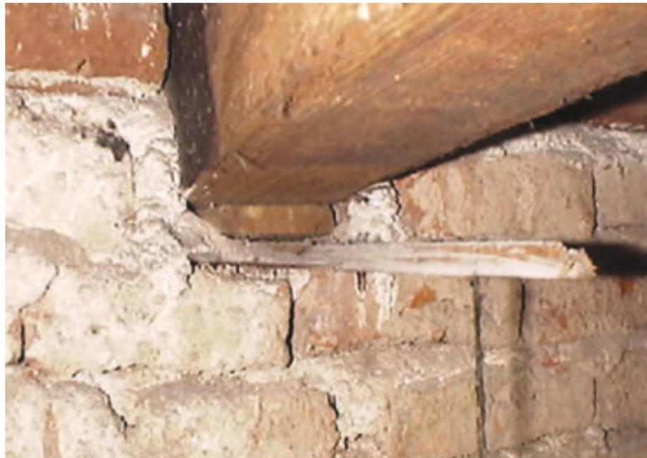
Fotografía 12. Detalle del asentamiento de las vigas de sostén de la caja s/muro.
