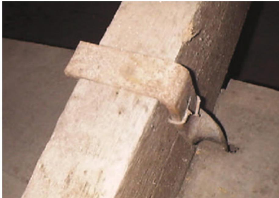
Fotografía 9. Detalle superior de una grampa de sujeción.
