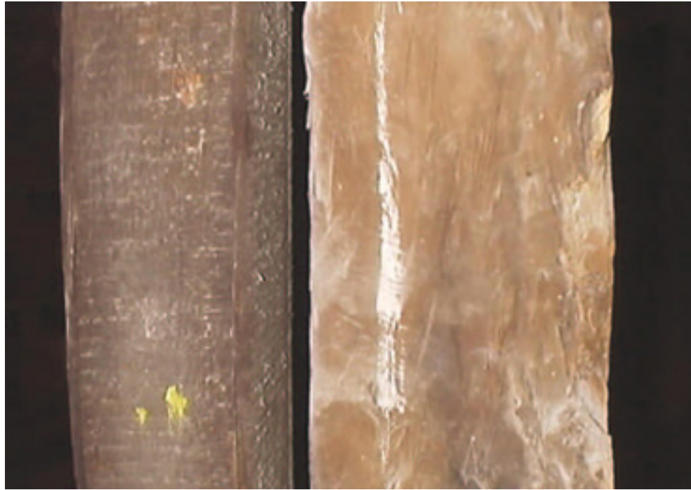
Fotografía 1. Detalle de los dos tipos de pilares presentes y sus respectivos cortes. El de madera dura y el de pinotea.
