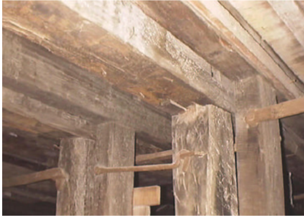
Fotografía 5. Detalle de encuentro entre pilar y viga superior. Se puede apreciar lo que muy probablemente sea un encastre a caja y espiga.
