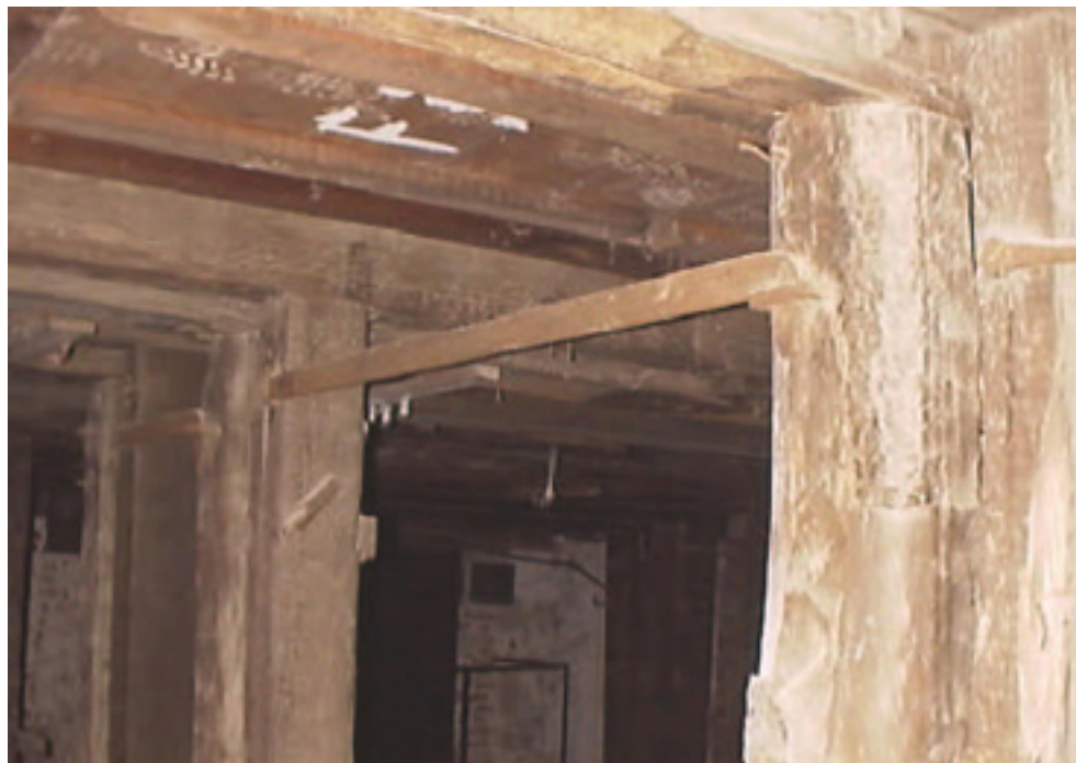
Fotografía 4. Detalle de los ganchos de hierro de arriostamiento entre pilares.
