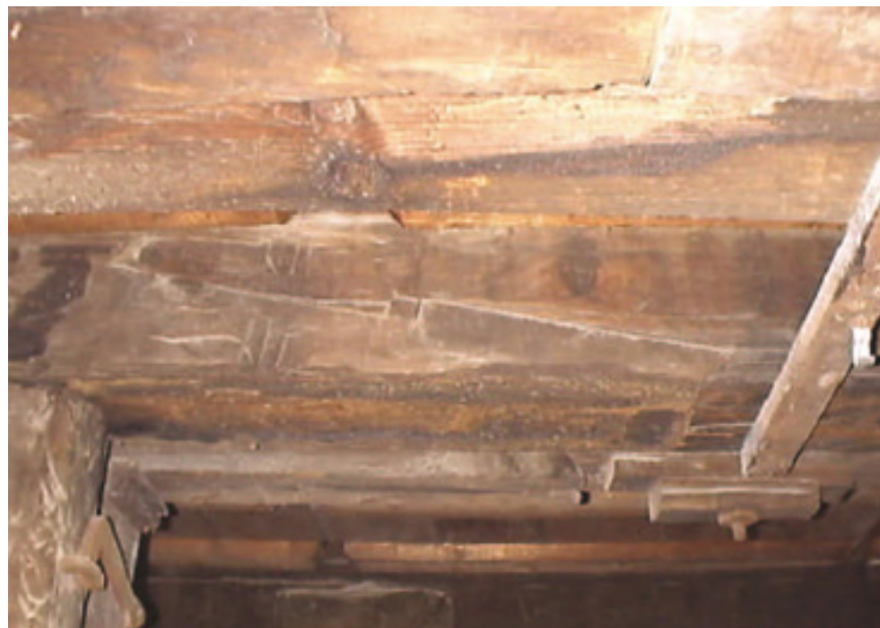
Fotografía 6. Detalle de ensambladura entre vigas superiores de madera dura: empalme en rayo de Júpiter con llave.
