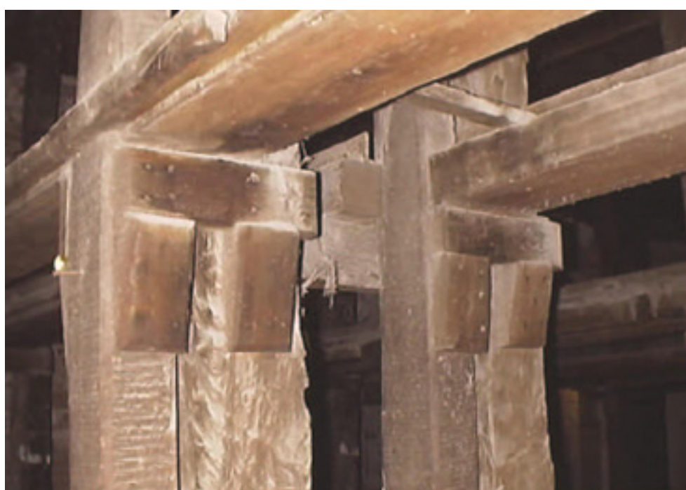
Fotografía 10. Detalle del encuentro de las vigas intermedias con los pilares.
