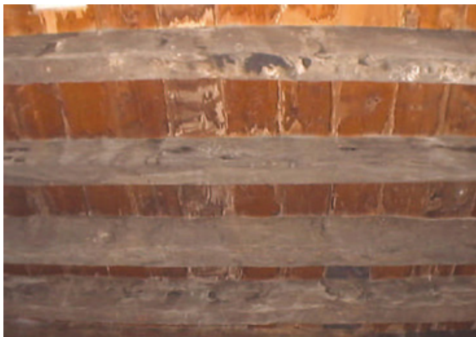
Fotografía 7. Detalle de tirantillos de madera dura y sector correspondiente a piso machihembrado del escenario.
