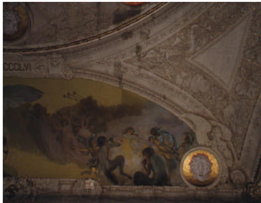
Fotografía 3. Parte derecha de la obra sobre el proscenio.
