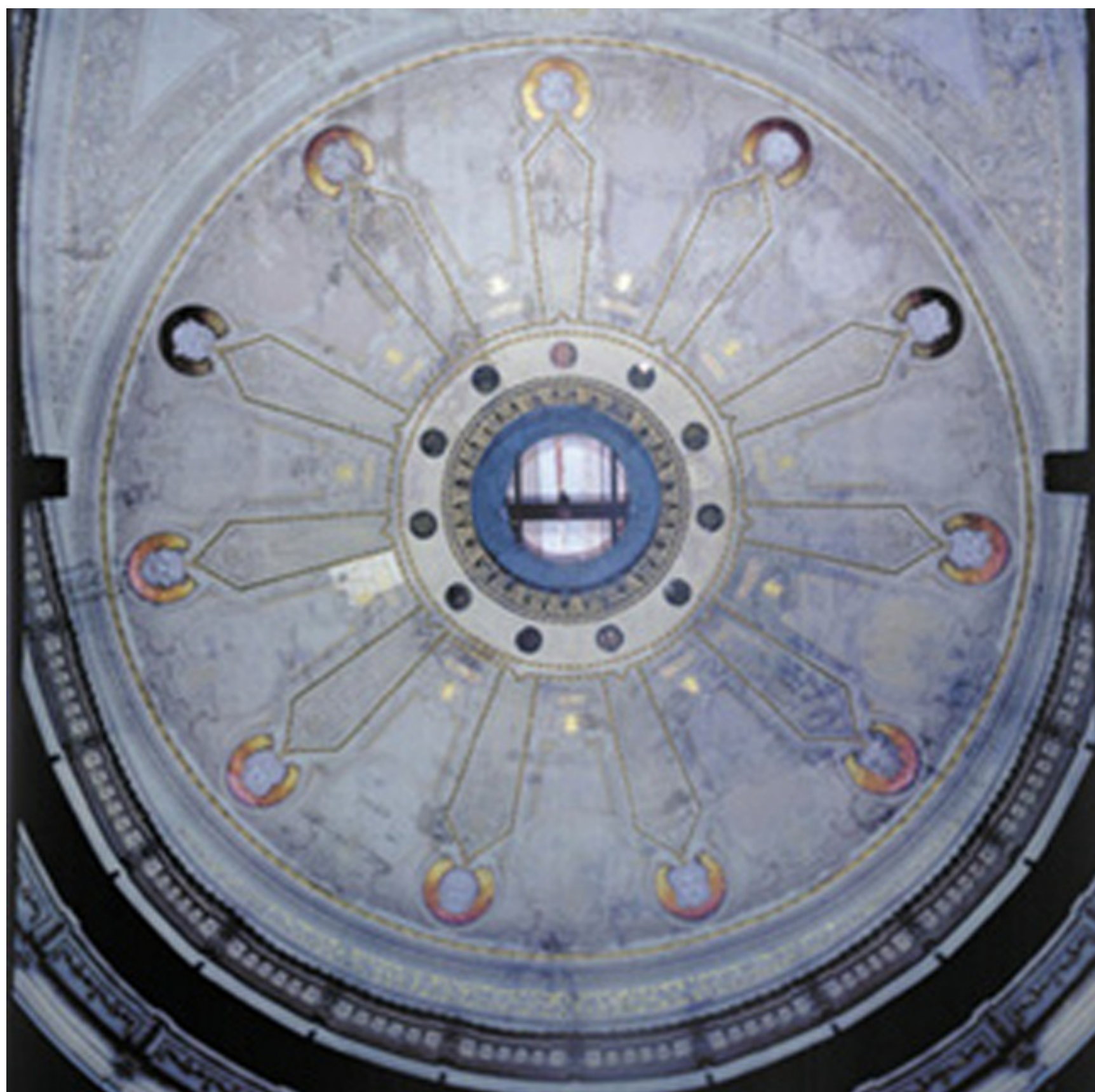
Fotografía 1. Sector central de la obra.
