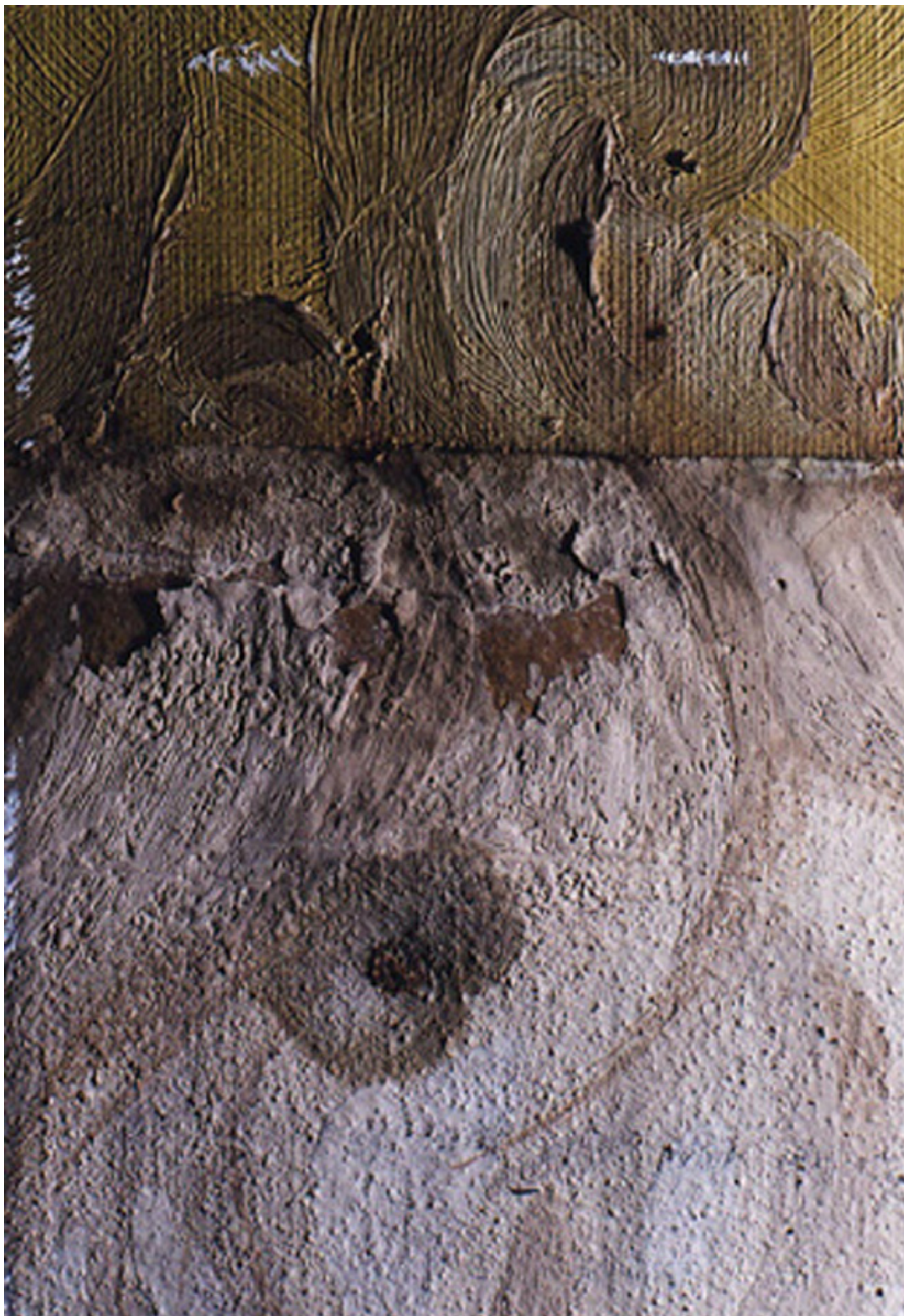
Fotografía 9. Detalle de una zona con levantamiento de la capa pictórica en la zona limítrofe con la obra sobre el proscenio.
