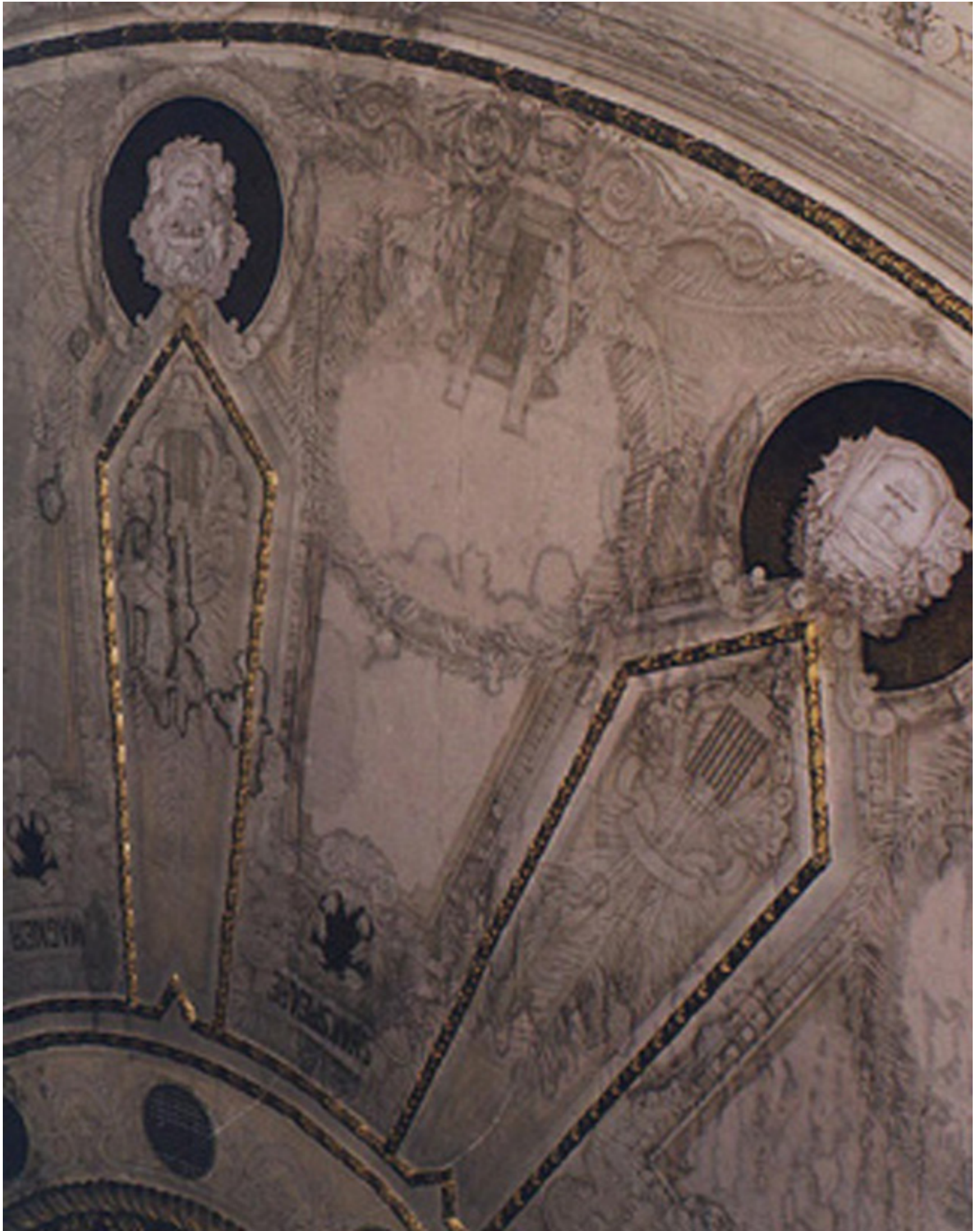
Fotografía 12: Zonas con repintes entre las coronas del plafond.
