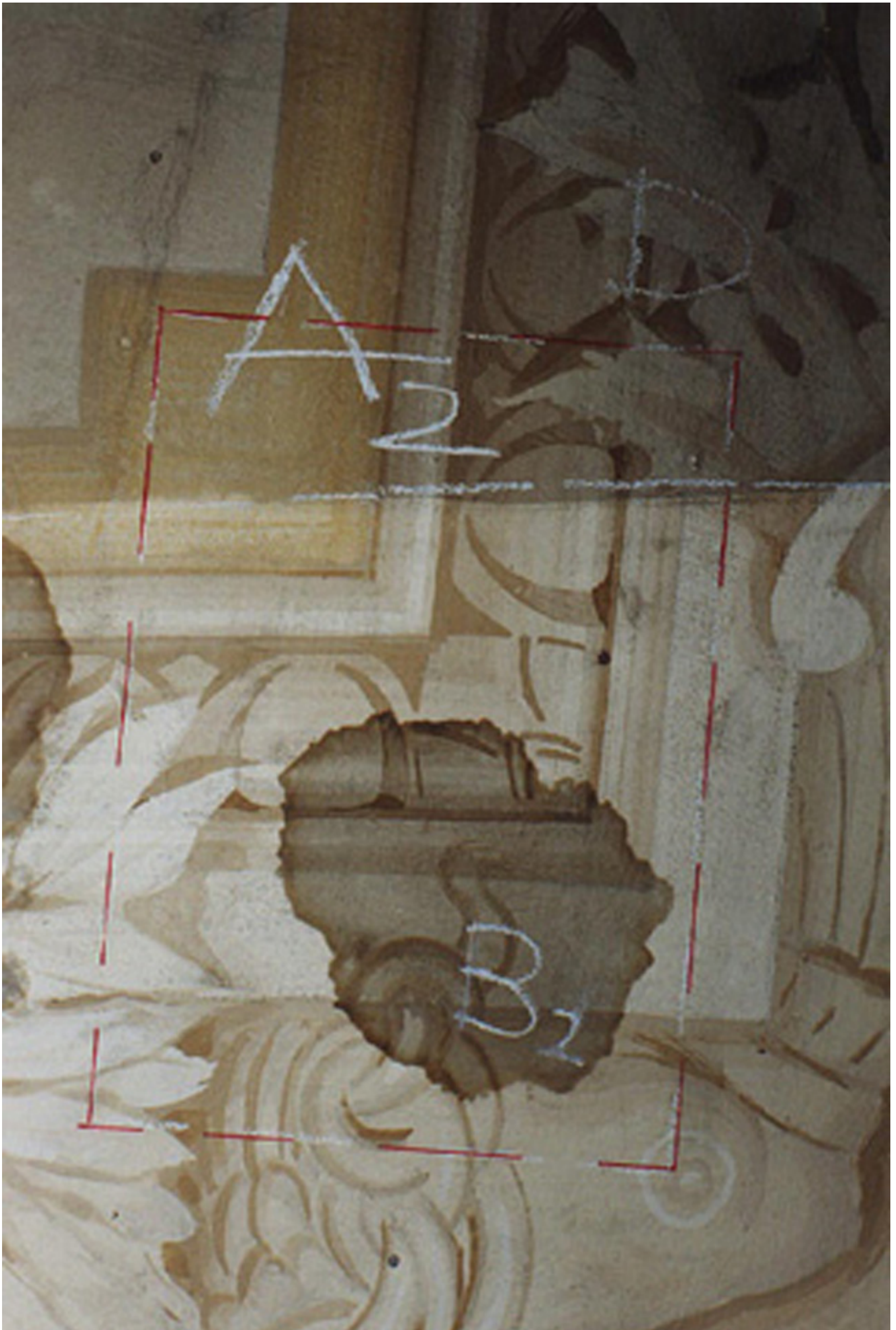
Fotografía 16: Detalle previo al tratamiento de reducción de manchas de humedad en la ventana D.
