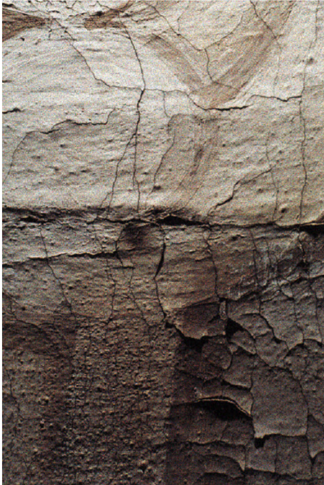
Fotografía 19. Detalle de la ventana H antes de la prueba de consolidación.
