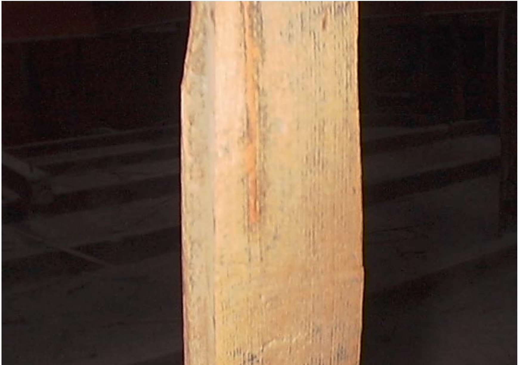
Fotografía 7. Detalle de gatel. Se aprecia el tipo de madera (pino blanco), así como su geometría irregular.
