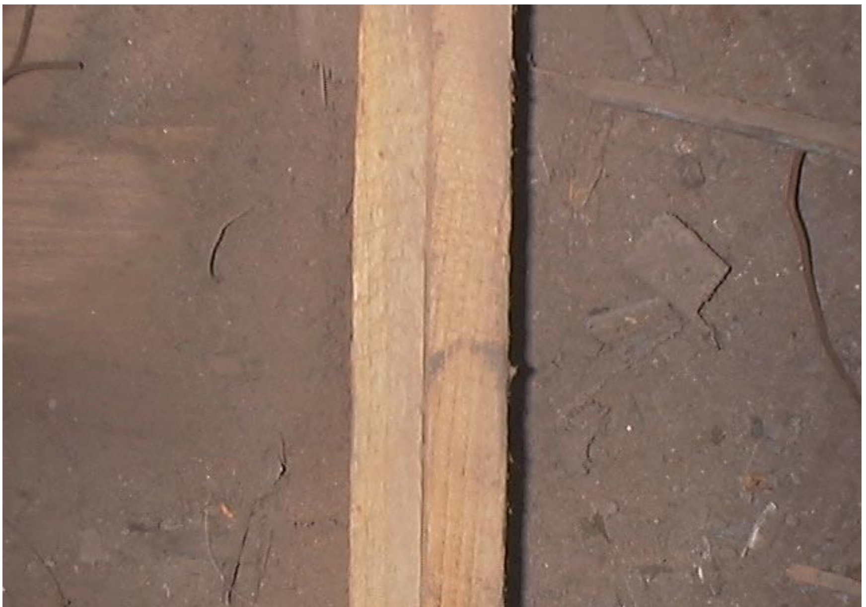
Fotografía 2. Vista superior de una costilla luego de aplicársele una limpieza con cepillo de paja. Se observan claramente el tipo de madera (pino blanco) y su construcción.
