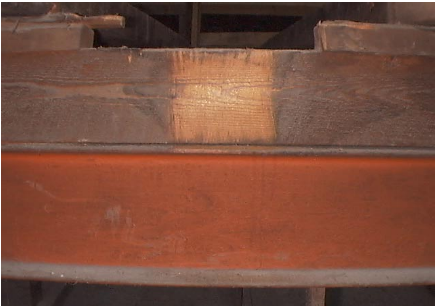
Fotografía 8. Detalle de las vigas de madera (pino blanco), ubicadas por encima de las vigas de hierro. A éstas se clavan los gatelos de los cuales cuelgan las costillas del plafond.
