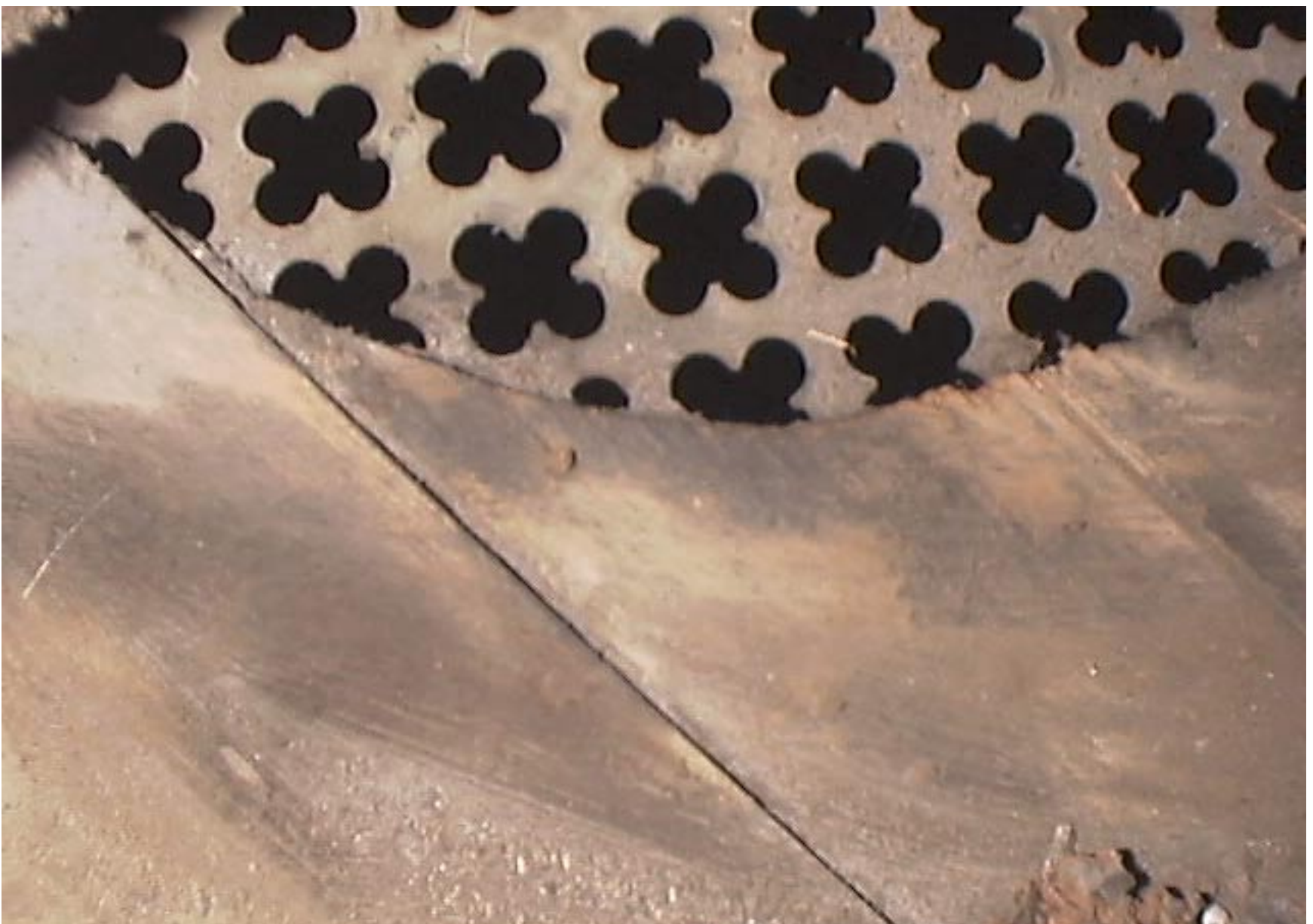
Fotografía 6. Detalle de perforación del entablonado del plafond para recibir desde abajo, a través de un aro de terminación, una rejilla de bronce de ventilación. Se aprecian claramente las sujeciones de dichas rejillas a la madera a través de tornillos.
