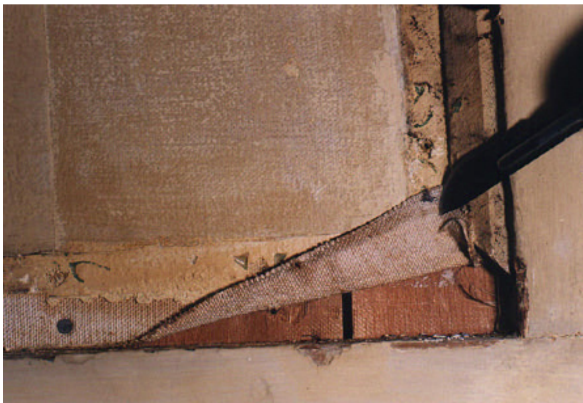
Fotografía 5. Detalle del borde inferior derecho del rectángulo central del frente de palco. Se observan las tablas detrás de la tela.
