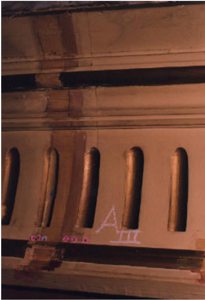
Fotografía 11. Superficie en estudio. Parte inferior del frente de palco.
