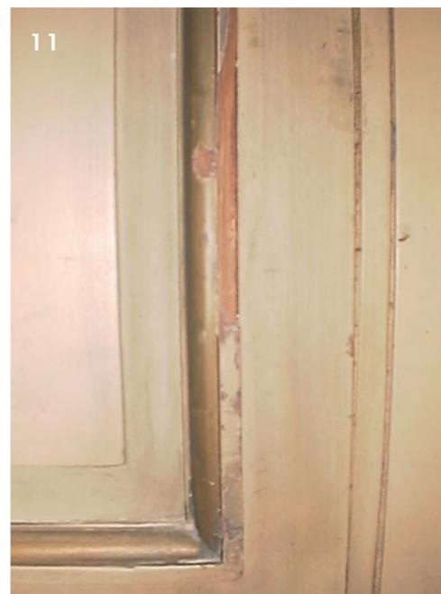
b) *Perforaciones en travesaños.* Este tipo de huecos ubicados en los travesaños superiores se debe al alojamiento de cajas de registros de instalación eléctrica. Su recuperación se realiza a través de empatilladuras en dichos travesaños (fotografías 12 y 13).
