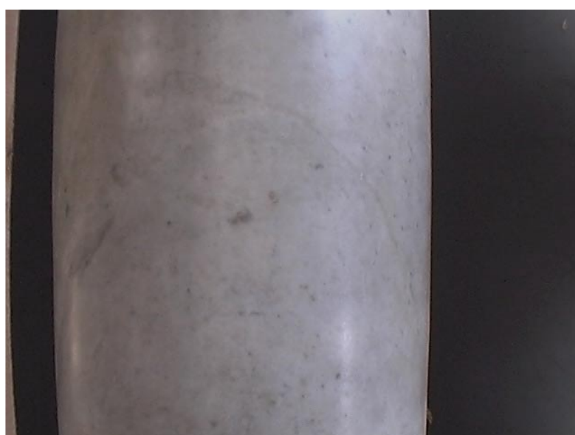
Se observa un sector de columna en el estado previo a su limpieza.
