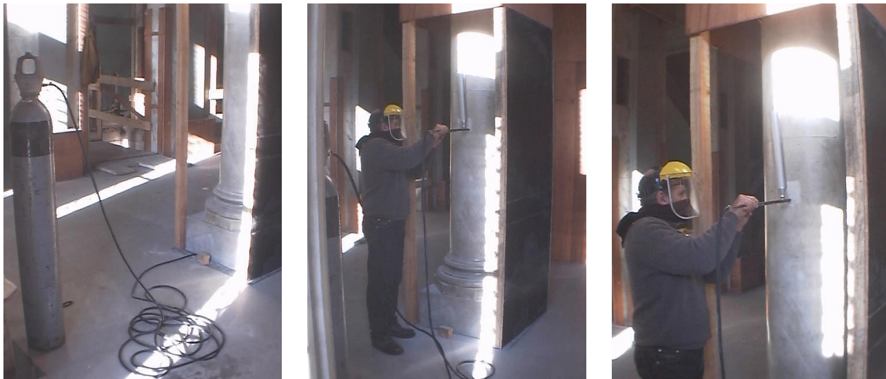
Limpieza de un sector de superficie de la columna realizada con microesferas de vidrio nº 200 impulsadas por nitrógeno.
