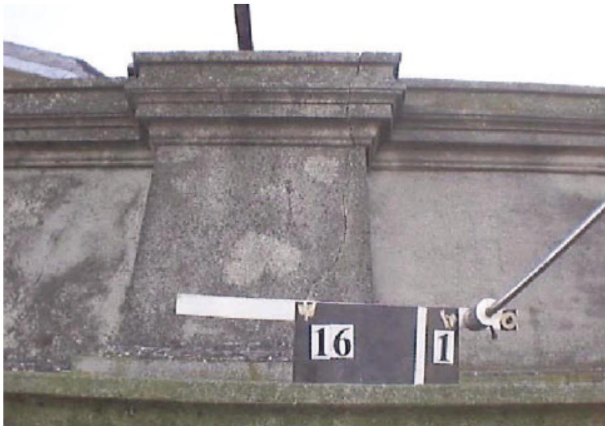
En la toma 17/1 se observa en las dos imágenes la destrucción estructural parcial de los frisos de abertura. Es un ejemplo nítido de pequeñas hidrataciones internas que traducen destrucción de barras de refuerzo y cambio de fortaleza de argamasa, que da como resultado dilataciones, como se puede observar en dichas tomas.
