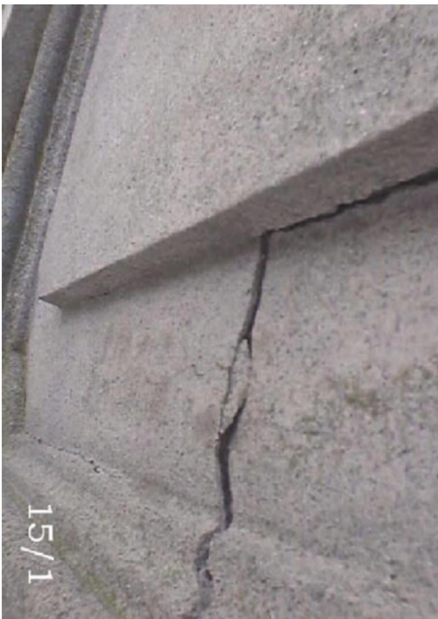
En la toma 16/1 se observa un fragmento de coronamiento, el cual permite ver una rajadura, algo que se repite en toda la extensión de la fachada n° 1 como prueba de las tensiones existentes en esa zona.
