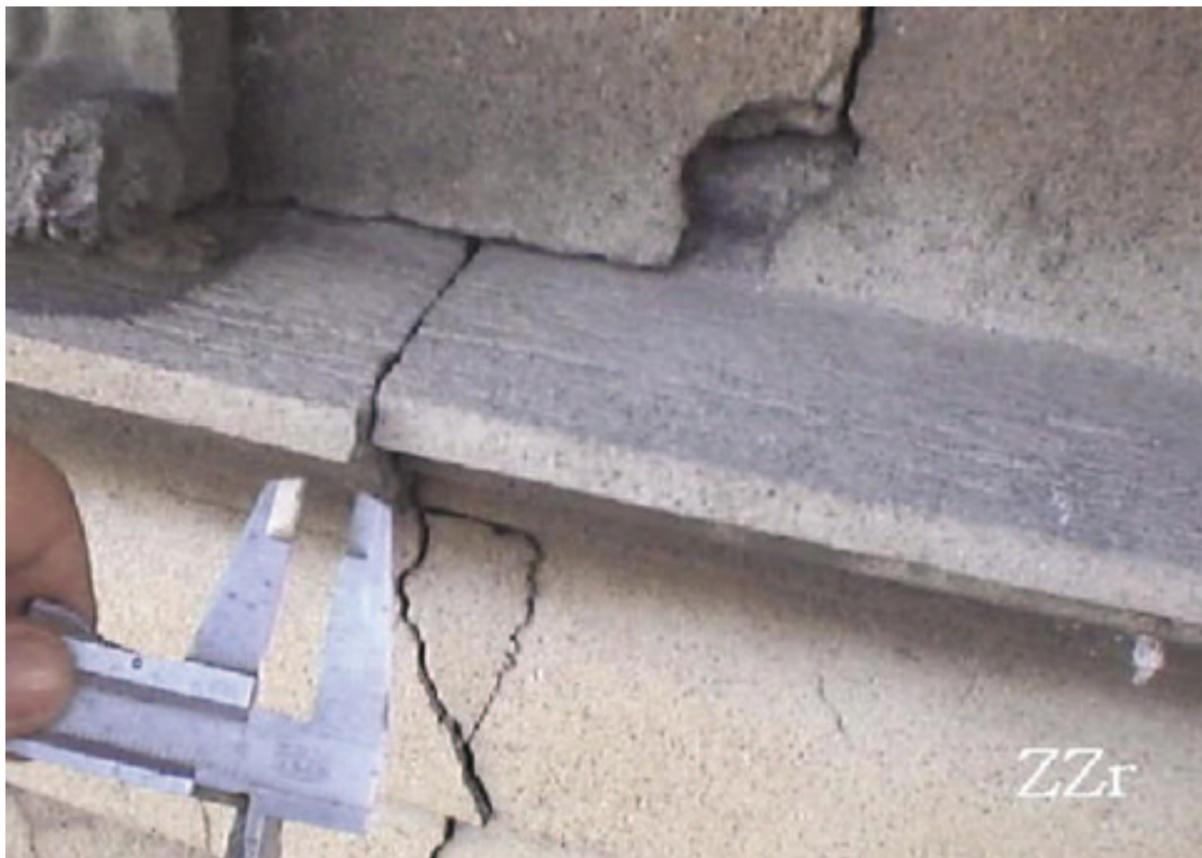
Las tomas observadas desde ZZa a ZZr, encierran una eflorescencia radical. Ésta se ha producido del interior hacia el exterior degradando hierros de contención, argamasa y revoque, produciendo choques de fuerza de materiales degradados y parcialmente degradados, haciendo peligrar que varios cientos de kilogramos de material se precipiten en esa ochava.
