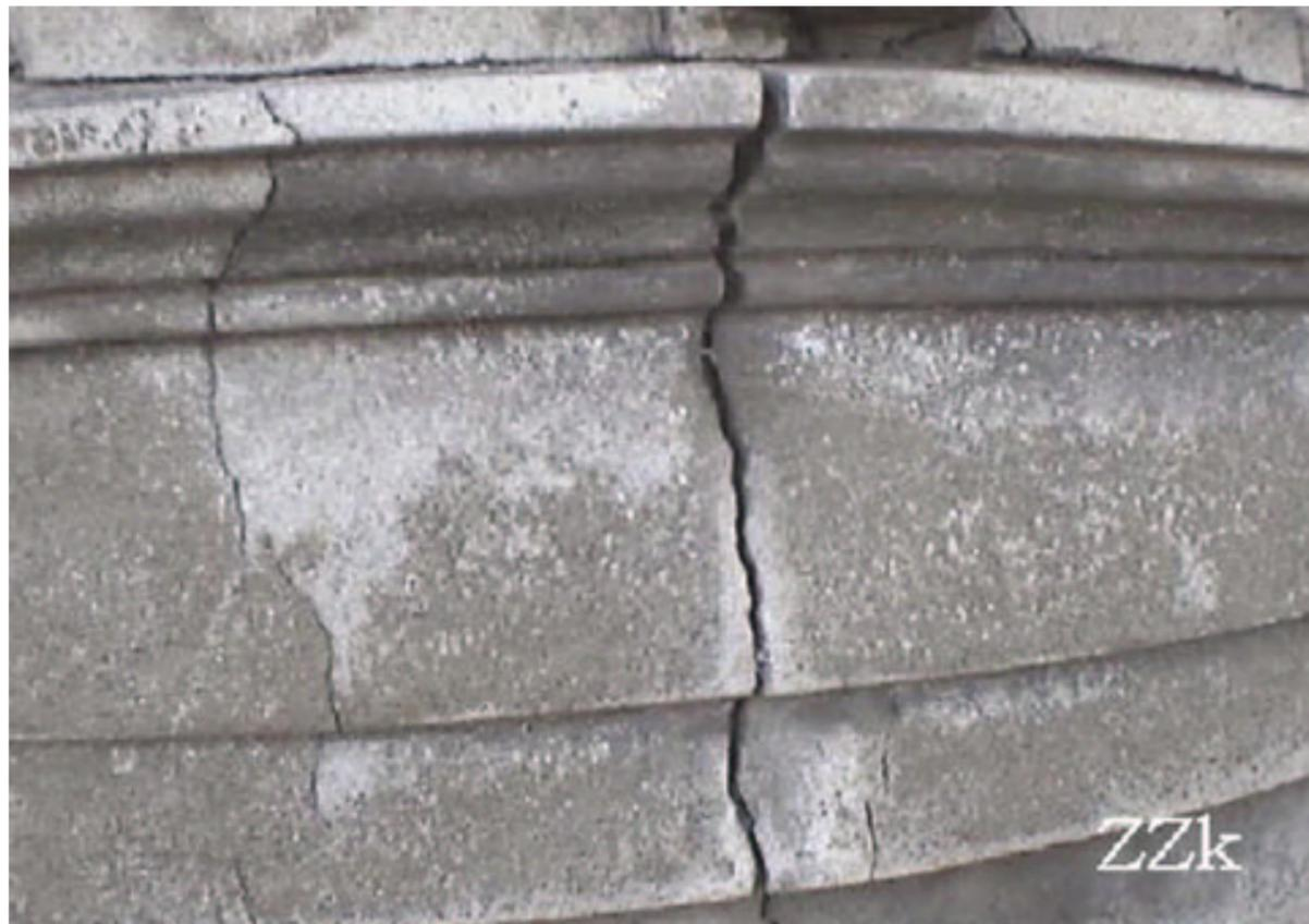
En las tomas ZZL y ZZLL, se muestra un modillón totalmente deteriorado en su camada superficial con eflorescencias parciales, acumulación de musgos y costra. Al ser tocado, una parte sustancial se desmoronó, quedando al descubierto las varillas de contención deterioradas, al igual que toda su estructura.
