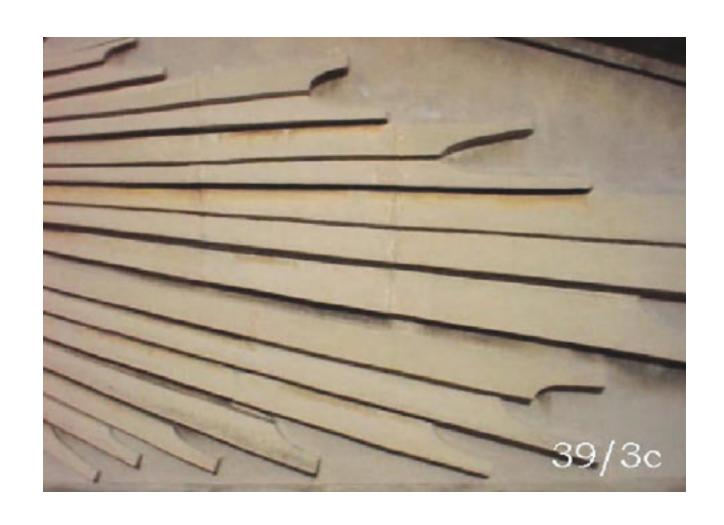
En la imagen 40/3 se muestran los dentículos en dos tomas, las cuales exhiben pequeñas fisuras en toda su extensión. Su firmeza es perfecta debido a la técnica de colocación, y su camada superficial presenta desgaste leve y homogéneo.
